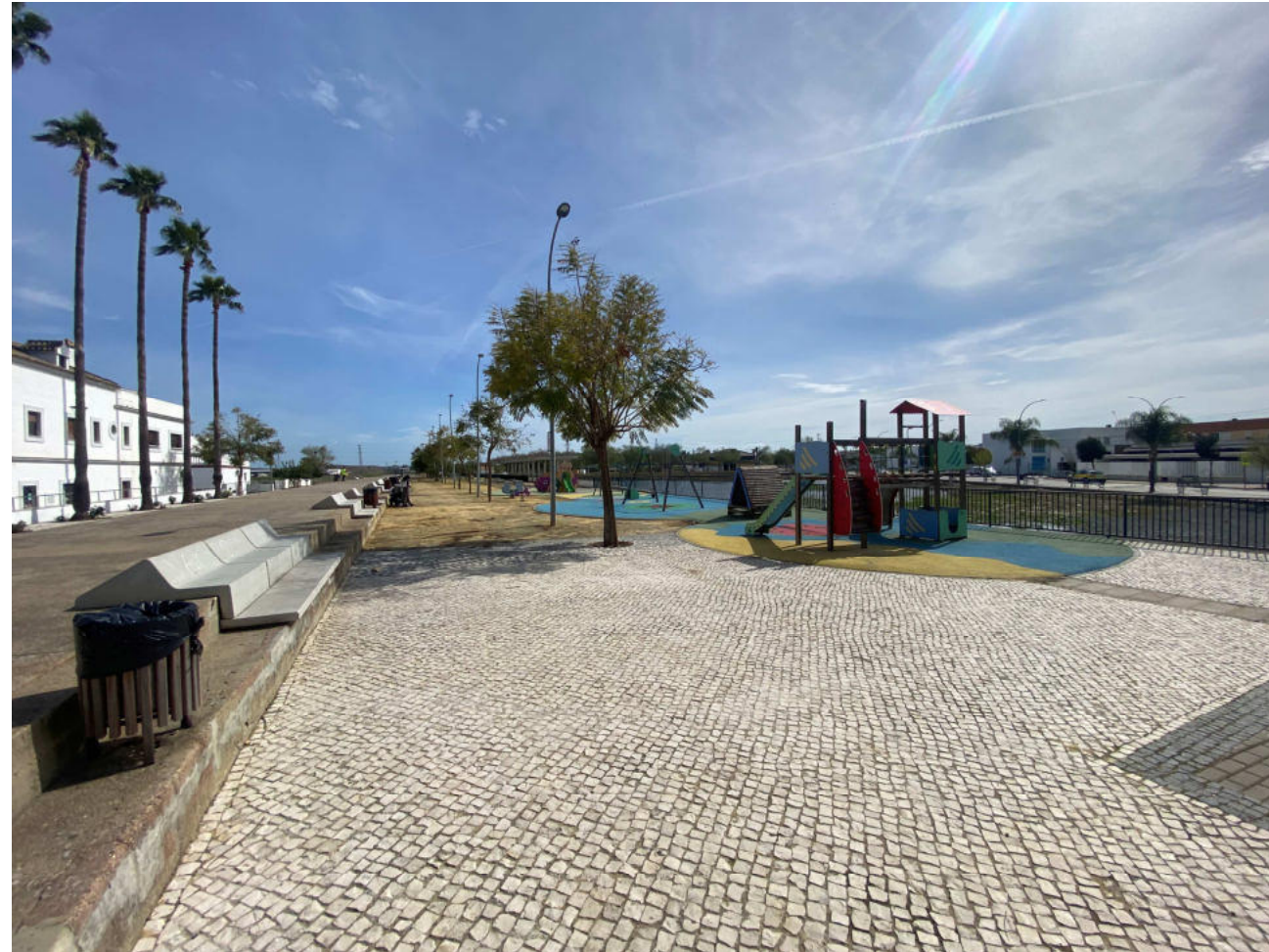
Fotografía_07. A la izquierda la cubrición original del canal de riego mediante banqueta sobreelevada.
