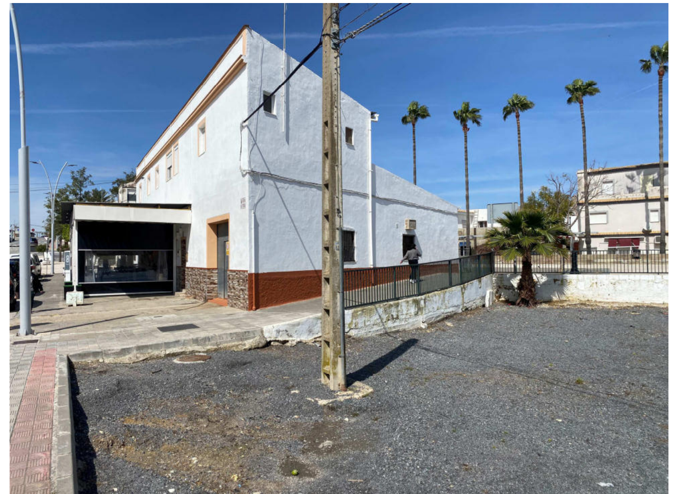
(Fotografía_12 . Vista de la edificación existente en la avenida de Utrera)
