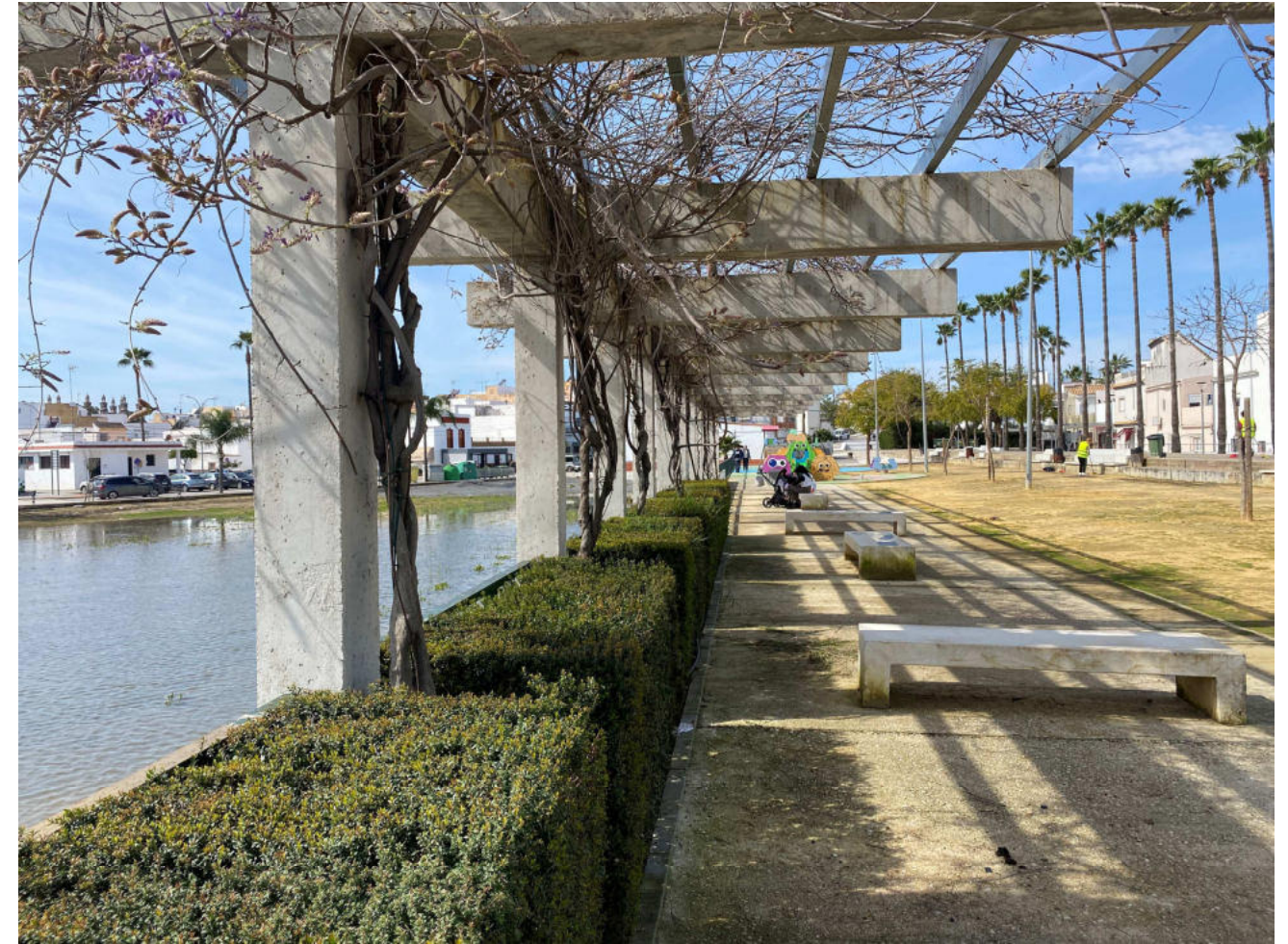
(Fotografía_16. Vista de la pérgola del parque lineal del canal de riego)
