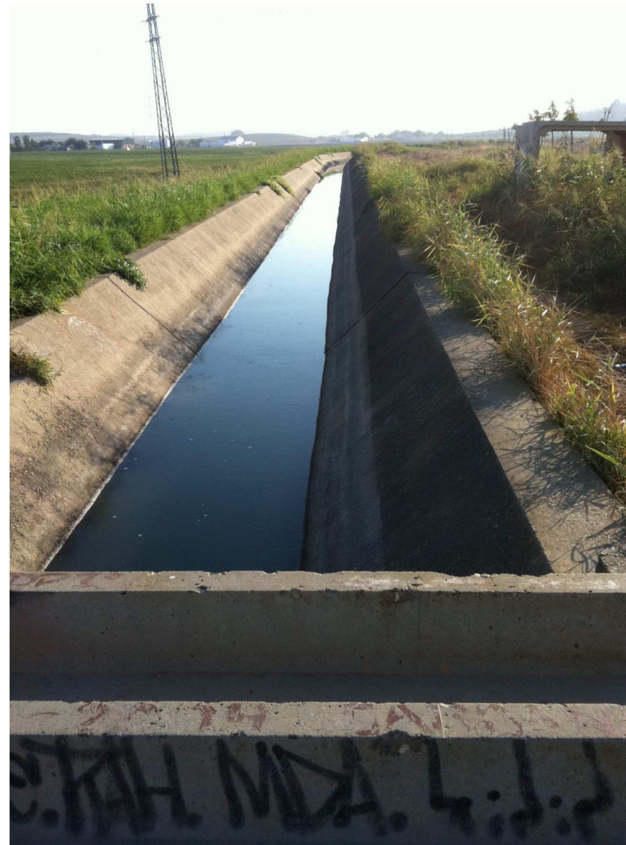
(Fotografía_27. Finalización del canal de riego cubierto. El canal hacia el pantano Torre del Águila)
