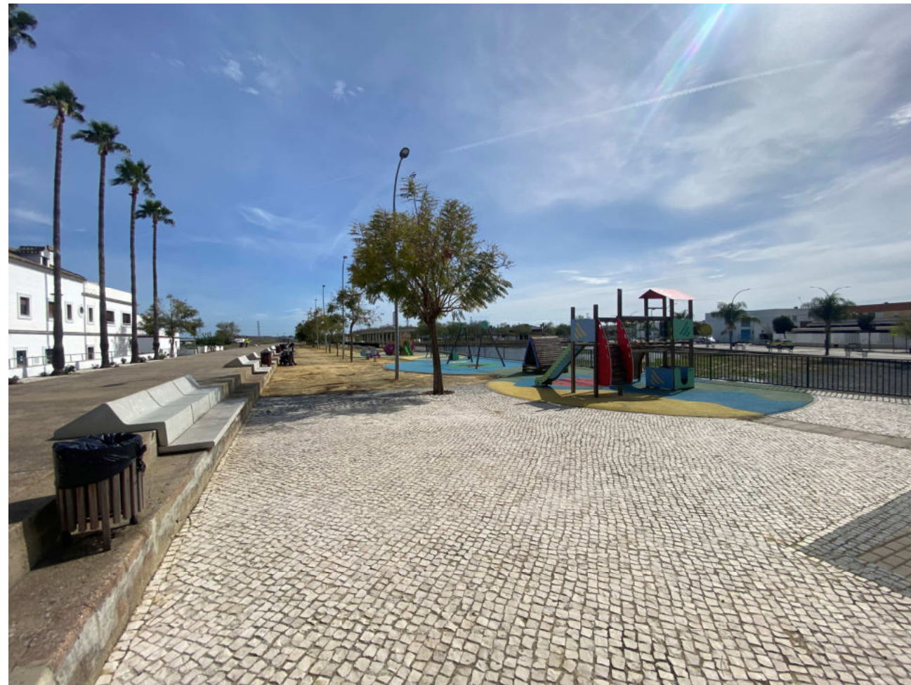
Fotografía_07. A la izquierda la cubierta original del canal de riego mediante banqueta sobreelevada.
