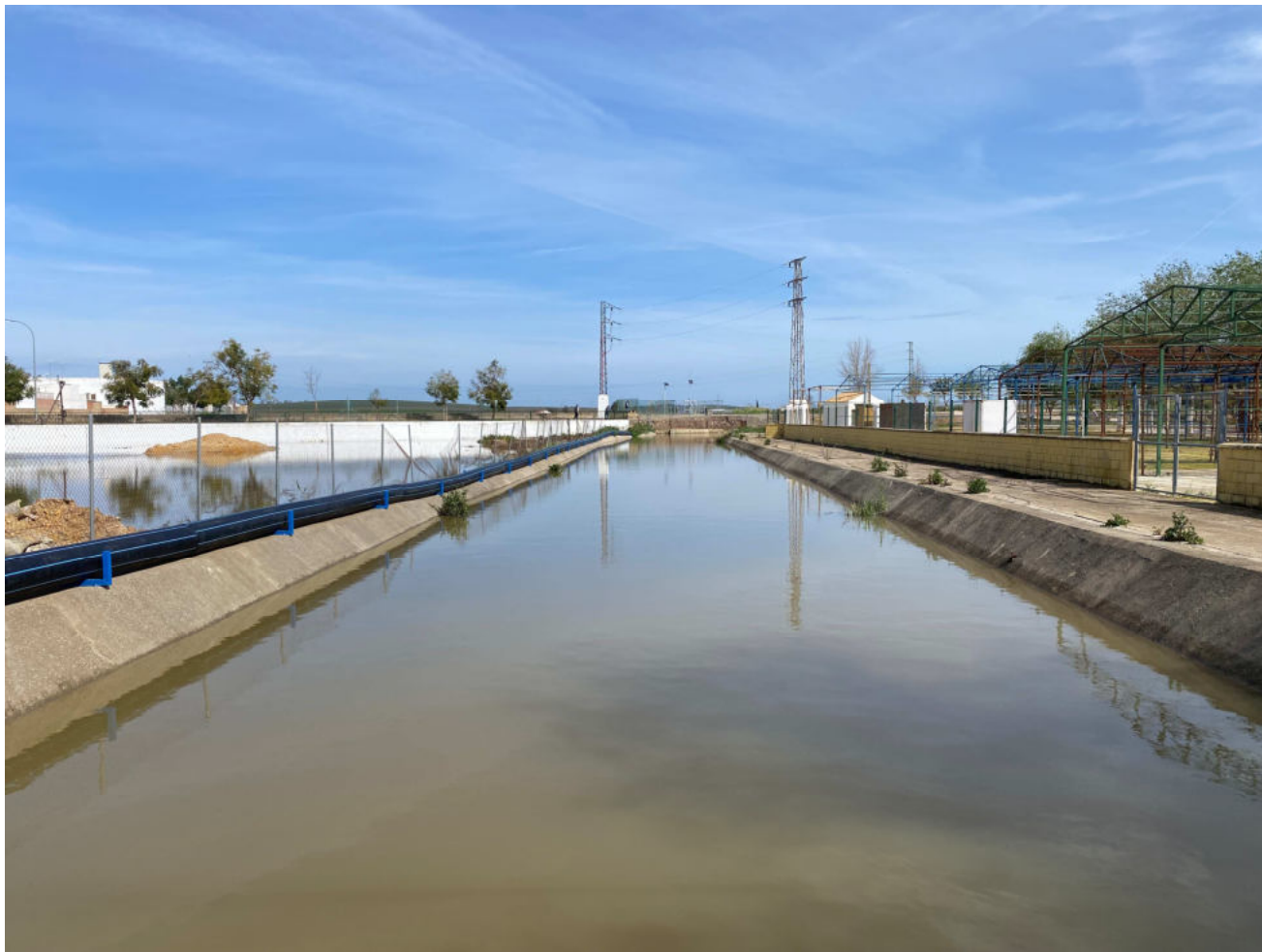
(Fotografía_17. Vista del desagüe del arroyo Salado de Morón)
