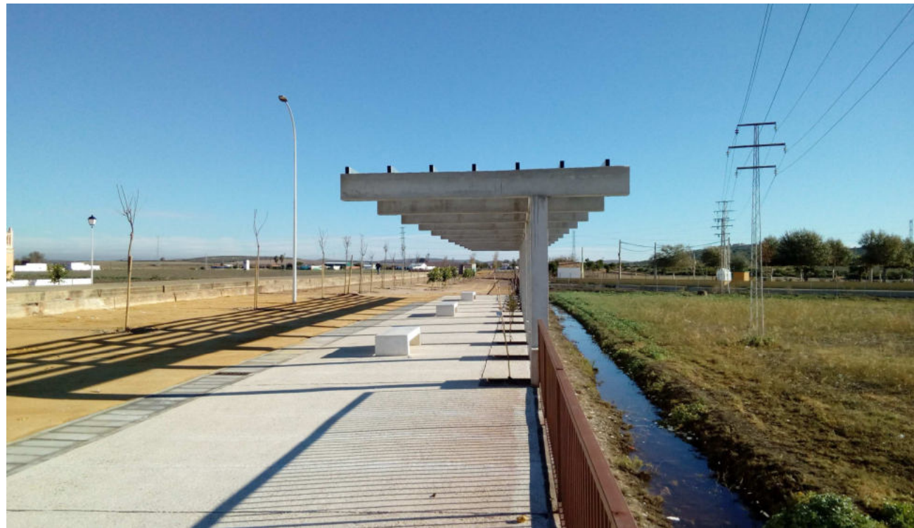
Fotografía 04. Vista de la zona de la pérgola y canal de riego
