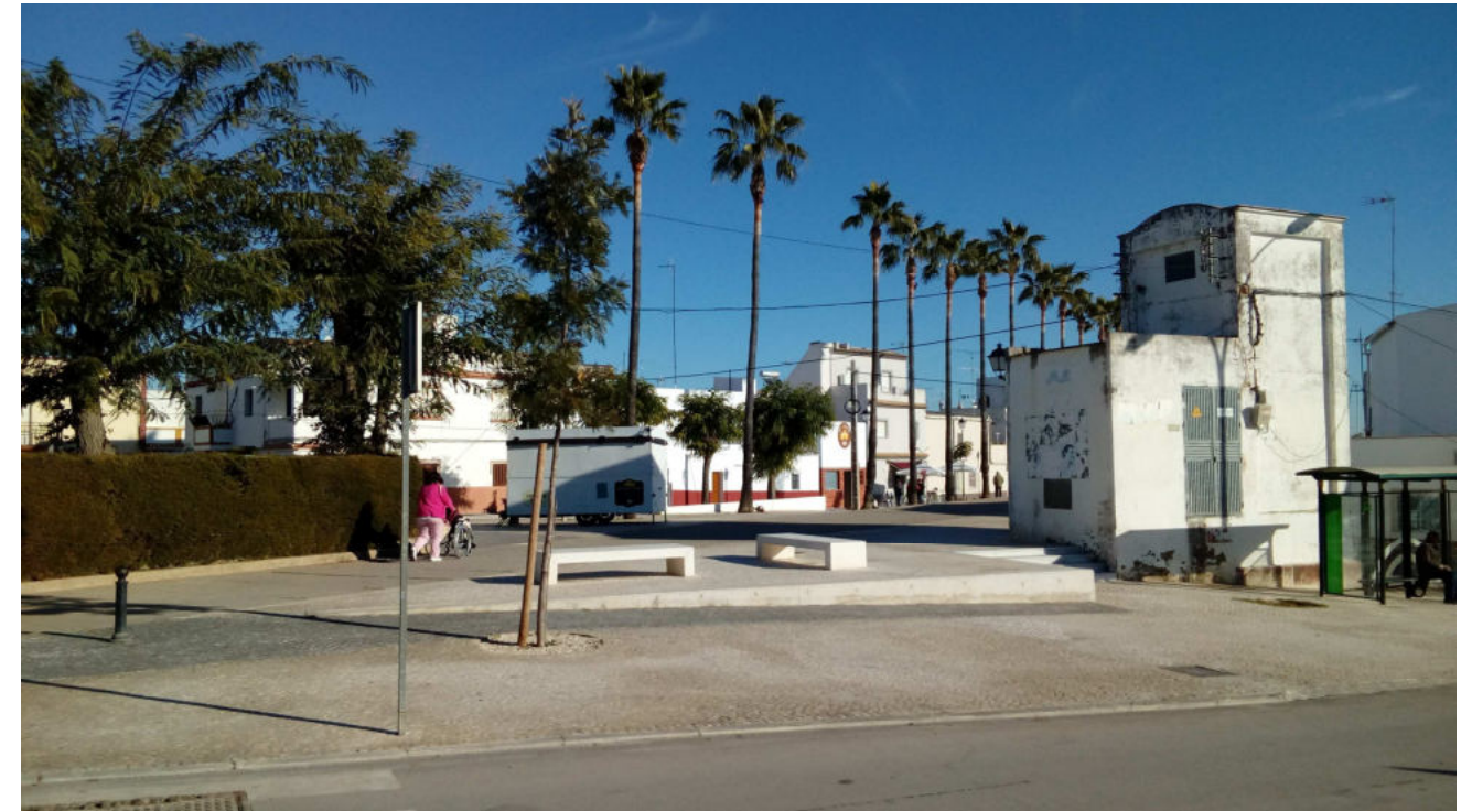
(Fotografía_22. Cabecera oeste del ámbito de actuación. Volumen del Centro de Transformación existente)
