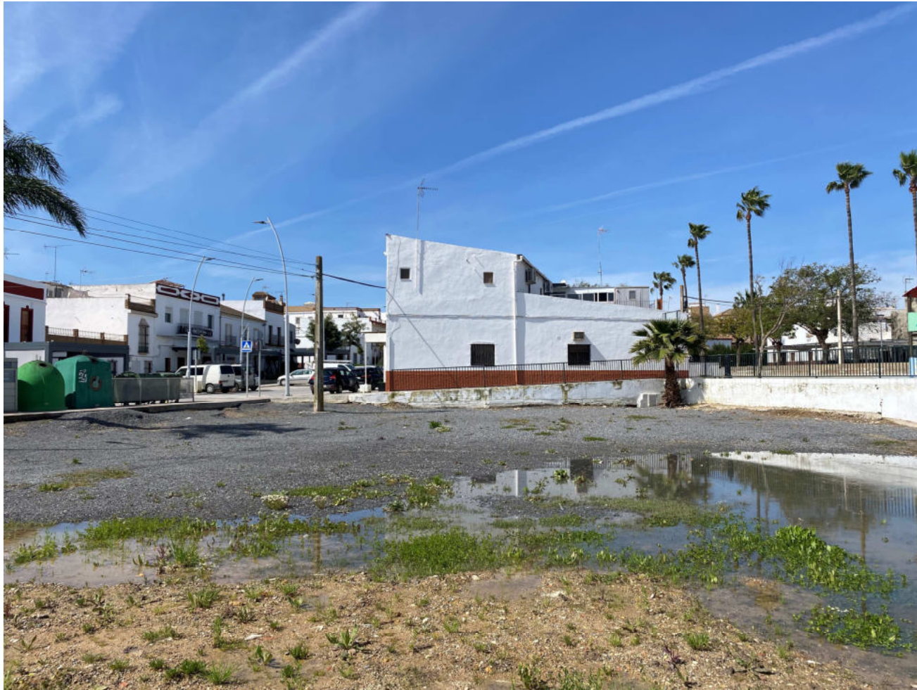
(Fotografía_13. Frente oeste área triangular)
