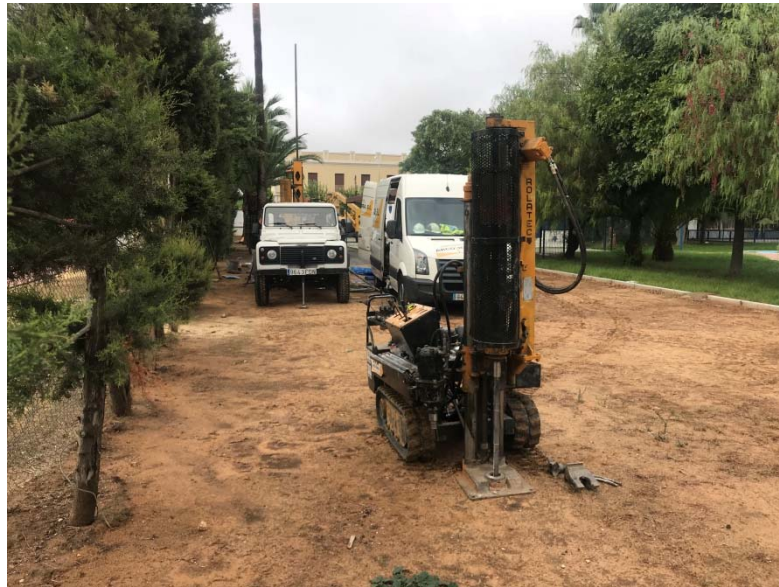
Foto 4.1. Aspecto actual de la parcela.
